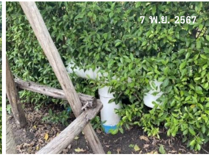
ท่อระบายอากาศจากบ่อเติมอากาศ
