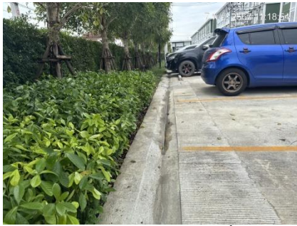
รางระบายน้ำและท่อระบายน้ำภายในโครงการ
